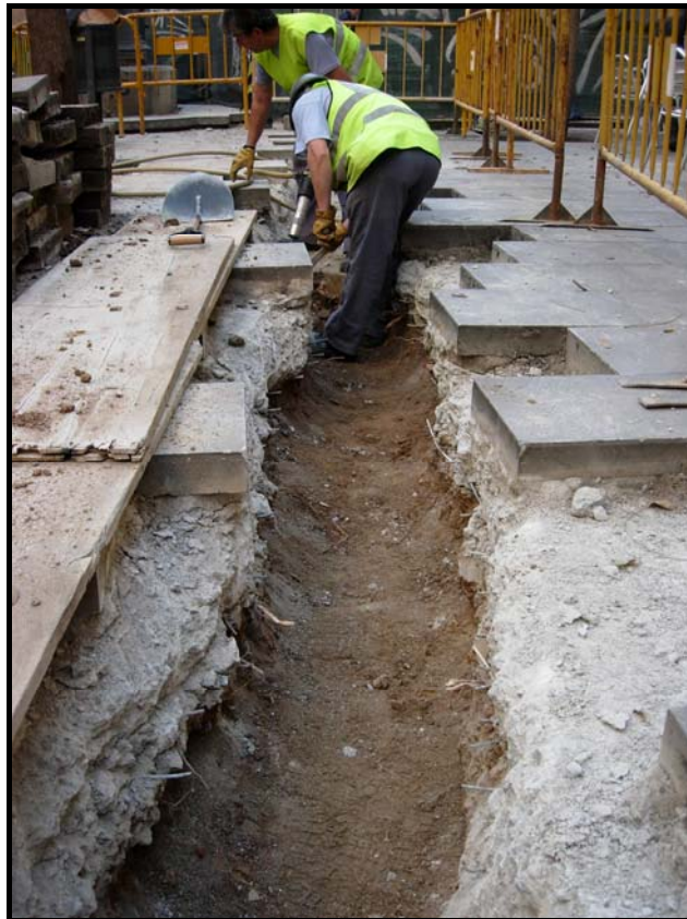
Foto 2. Treballs d'excavació de la rasa.
