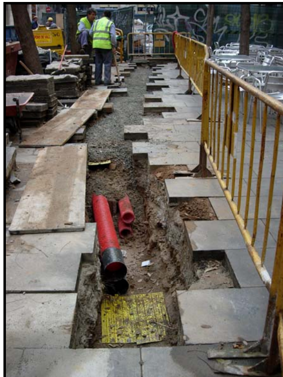
Foto 4. Col·locació dels tubs que portaran els cables.
