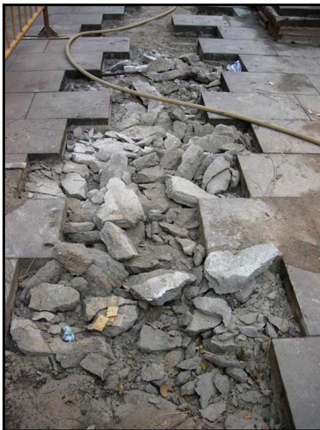
Foto 1. Desmuntatge del paviment de la Pl. Bonsuccés.
