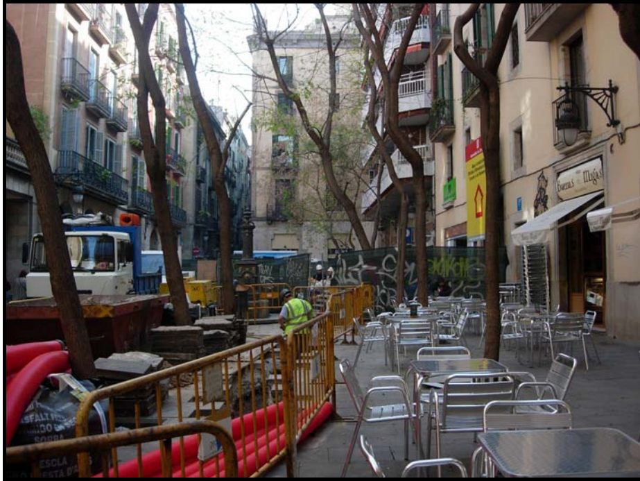
Foto 3. Aspecte de la Pl. Bonsuccés durant les obres d'excavació de la rasa.
